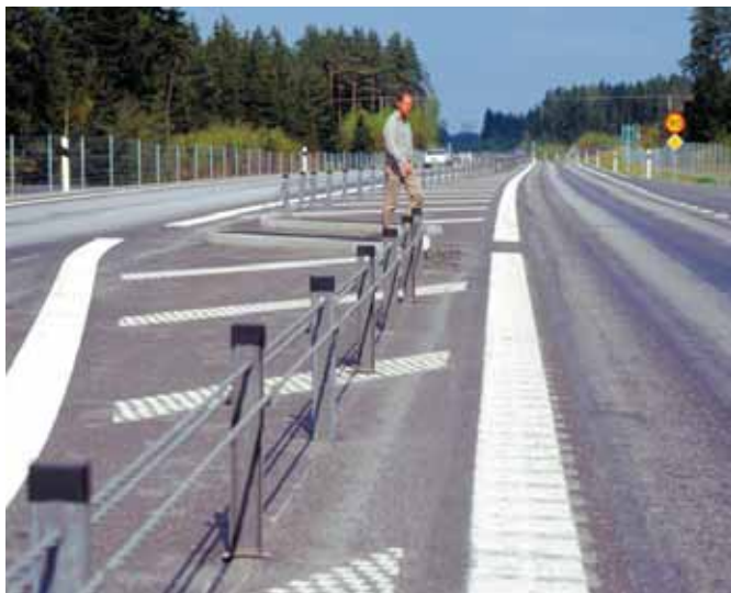
Exempel på mittö, där oskyddade trafikanter kan korsa vägen på ett trafiksäkert sätt.
