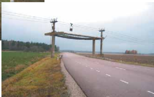
Kalklinbanan passerar över väg 56.
